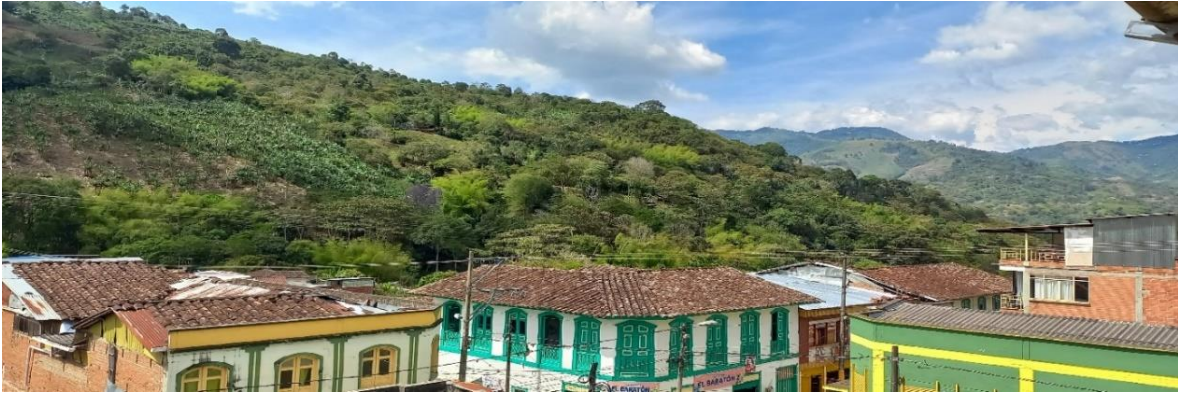
Fotografía: propia, 2023, municipio de Génova, Quindío
